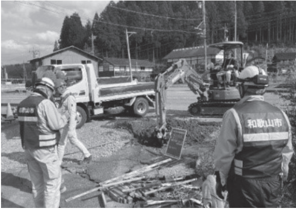
水道復旧工事
