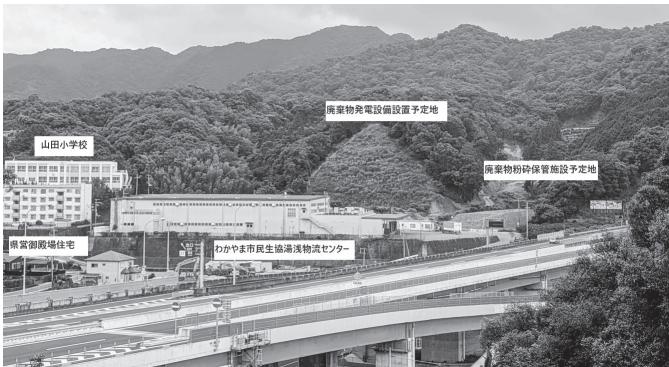
湯浅バイオマス発電建設予定地
